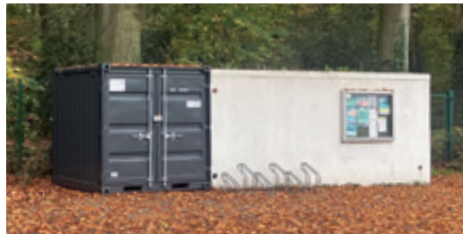
Ein neuer Container ist aufgestellt, der alte „entsorgt“.
